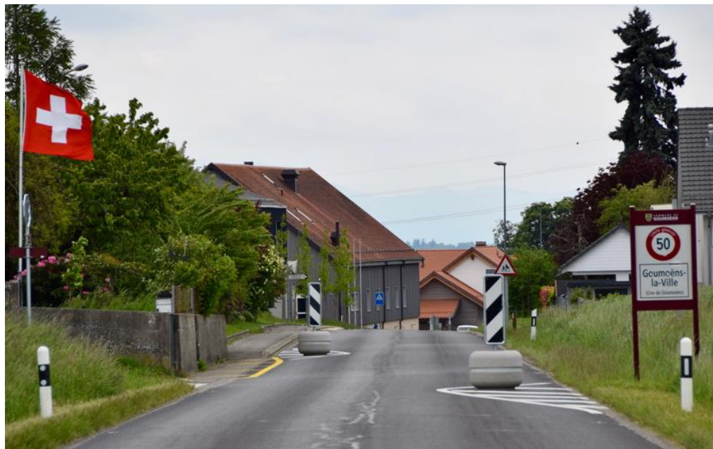
Modérateurs de trafic route de Penthéréaz
